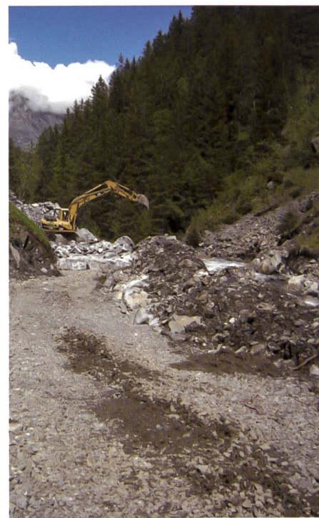
Bild 14. Zufahrtsstrasse zur Fassungsbaustelle im Juni 2008 mit umgeleittem Bach (rechts).
