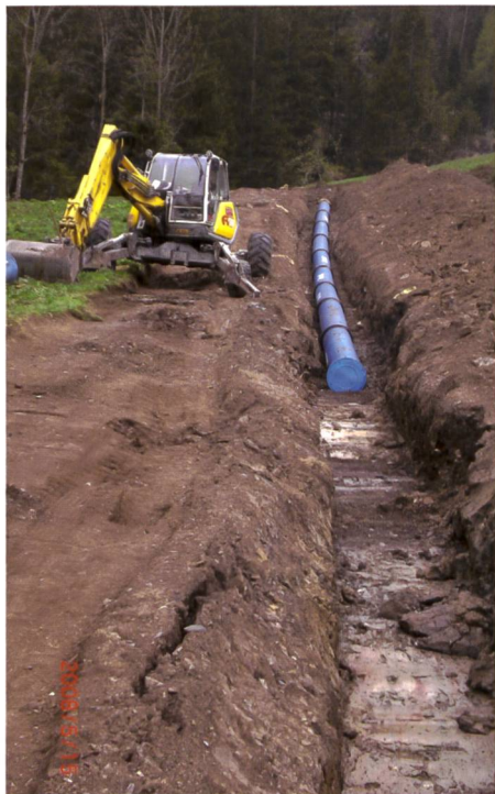
Bild 8. Versetzte Druckleitung in Etappe 1 (oberhalb Maschinenhaus).
