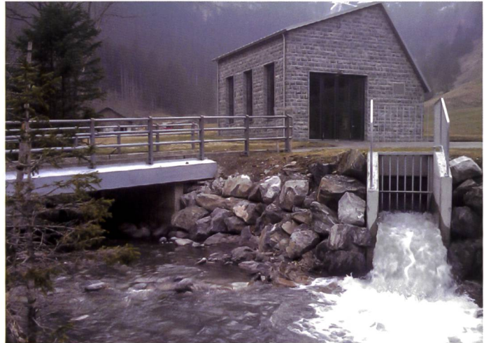
Bild 27. Maschinenhaus aussen mit UW-Kanal.
