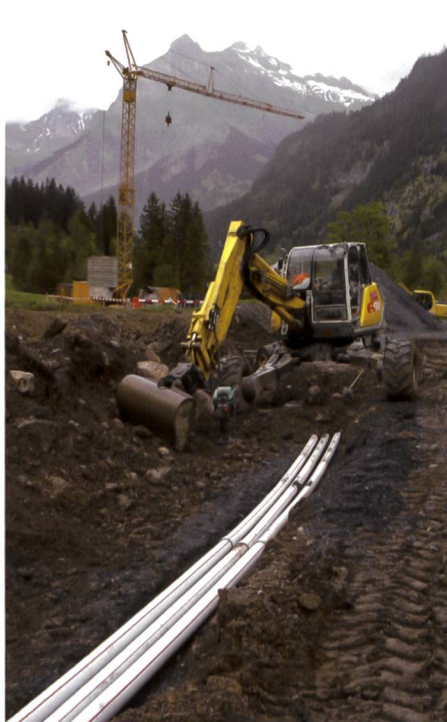
Bild 9. Eindecken der 3 Kabelschutzrohre in Etappe 1 (oberhalb Maschinenhaus).
