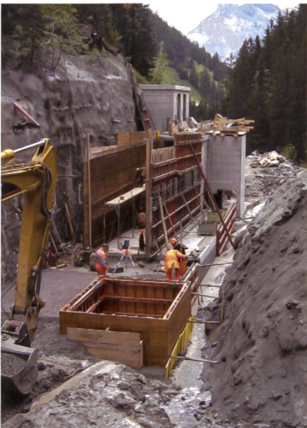
Bild 17. Sicht auf eingeschaltetes Entsandbauwerk (rechts Damm mit Bachumleitung).
