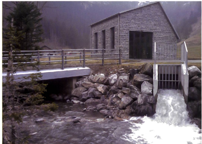
Bild 27. Maschinenhaus aussen mit UW-Kanal.
