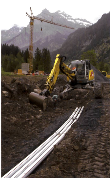
Bild 9. Eindecken der 3 Kabelschutzrohre in Etappe 1 (oberhalb Maschinenhaus).
