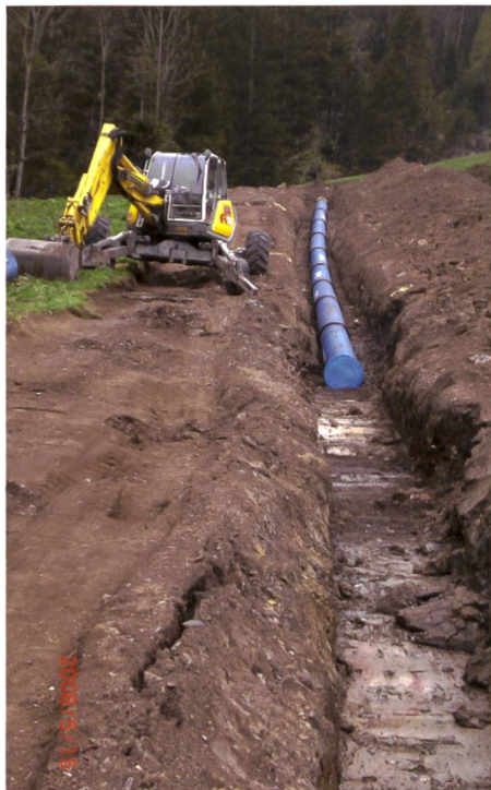
Bild 8. Versetzte Druckleitung in Etappe 1 (oberhalb Maschinenhaus).
