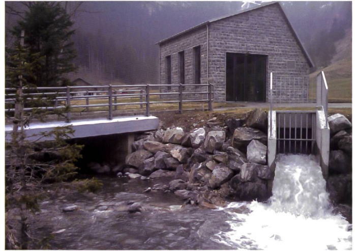
Bild 27. Maschinenhaus aussen mit UW-Kanal.
