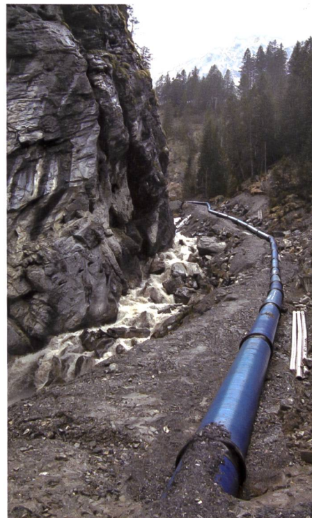
Bild 12. Versetzte Druckleitung in Etappe 4 im Dezember 2008.
