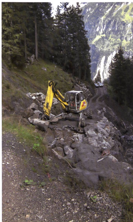
Bild 11. Erstellen Baupiste als Fundament für Druckleitung in Etappe 4.
