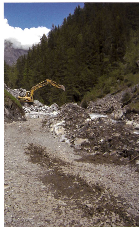
Bild 14. Zufahrtsstrasse zur Fassungsbaustelle im Juni 2008 mit umgeleiteten Bach (rechts).
