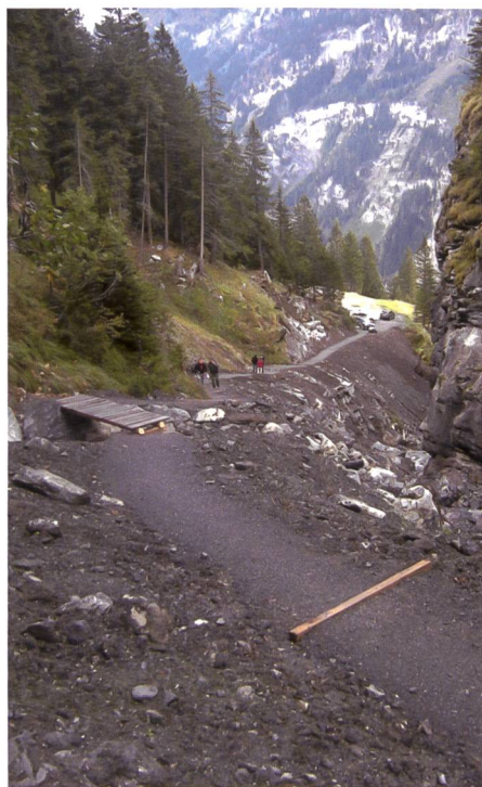
Bild 13. Eingedeckte Druckleitung in Etappe 4 mit neuem Wanderweg im Herbst 2009.
