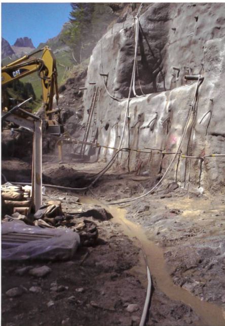
Bild 15. Nagelwand bei Fassung.
