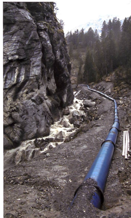
Bild 12. Versetzte Druckleitung in Etappe 4 im Dezember 2008.
