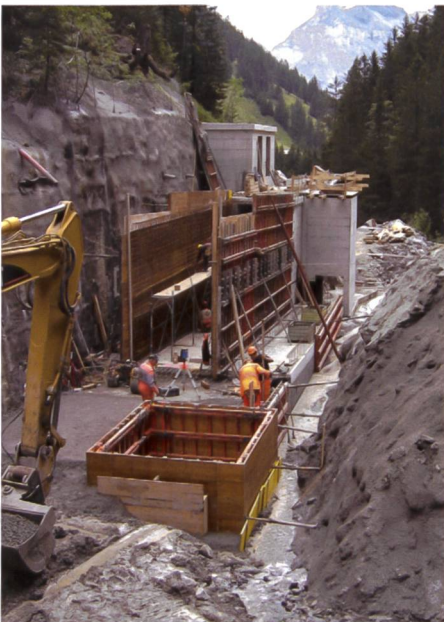
Bild 17. Sicht auf eingeschaltes Entsanderbauwerk (rechts Damm mit Bachumleitung).
