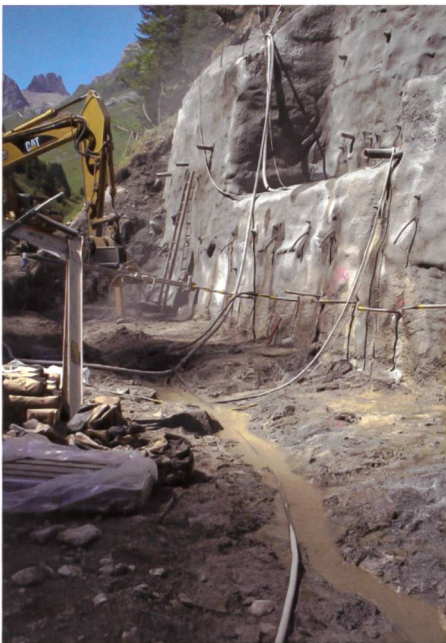
Bild 15. Nagelwand bei Fassung.
