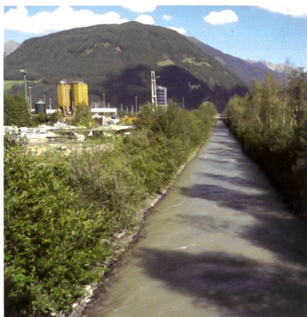
Bild 2. Hart verbauter Abschnitt am Unteren Mareiter Bach, Blick flussabwärts.
