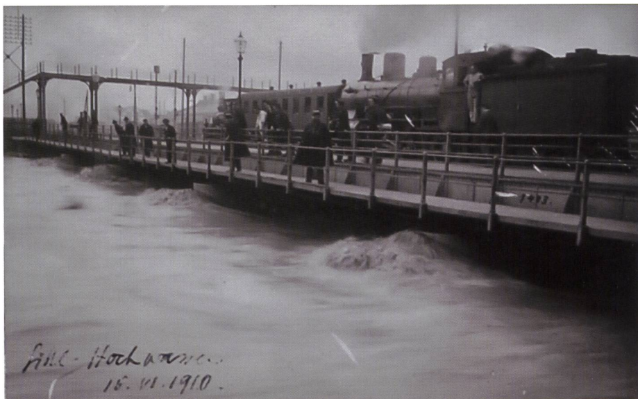
Bild 4. Die hoch gehende Sihl 1910 bei den Durchlässen am Zürcher Hauptbahnhof mit ausgeschöpfter Abflusskapazität.
