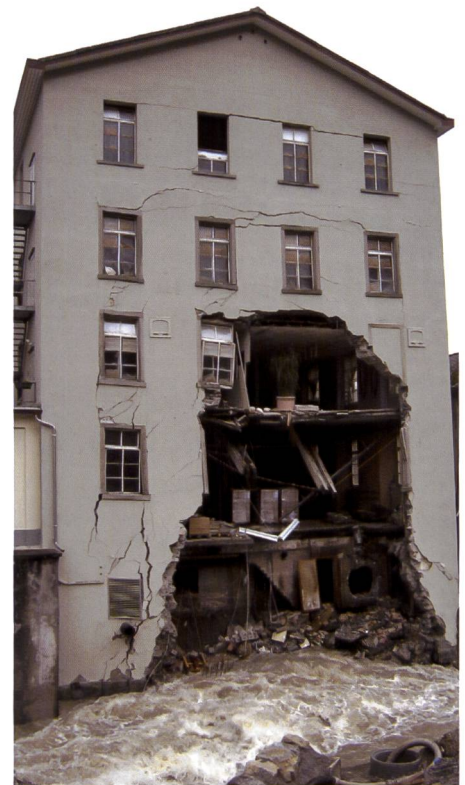
Bild 8. In Ziegelbrücke GL unterspülte die Rauti am 6. August eine alte Spinnerei (Kantonspolizei Glarus).
