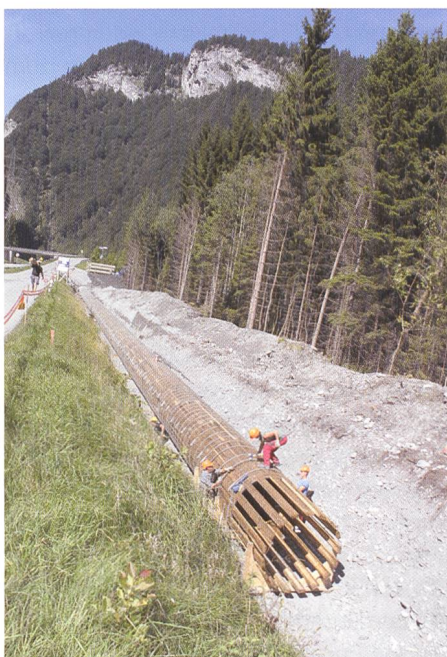
Bau der Holzleitung.
