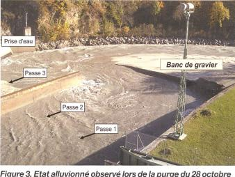
Figure 3. Etat alluvionné observé lors de la purge du 28 octobre 2005 (vue de l'aval, rive gauche).
