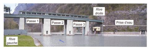
Figure 1. Le barrage de Lavey. Vue d'amont (photo 2005).
