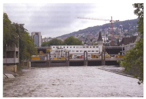
Bild 1. Die Sihl fliesst unter dem Hauptbahnhof Zürich hindurch. Zwei der insgesamt fünf Durchlässe waren (zum Zeitpunkt der Aufnahme) mit Fluttoren geschlossen, welche im Falle einer Baustellenflutung geöffnet werden könnten. Aufnahmedatum: 14. Juli 2008; Abfluss rund 105 m³ s⁻¹; Aufnahme von Oberstrom.
