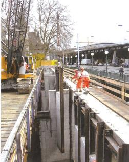
Bild 5. Fluttore unterstrom (links): Spundwandbohlen im Wechsel mit Betonelementen. Im Rahmen einer Baustellenflutung werden diese Elemente mittels Seilbagger hochgezogen (rechts) (Quelle: igzalo).
