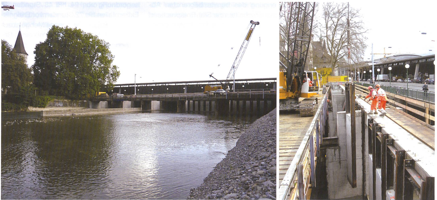
Bild 5. Fluttore unterstrom (links): Spundwandbohlen im Wechsel mit Betonelementen. Im Rahmen einer Baustellenflutung werden diese Elemente mittels Seilbagger hochgezogen (rechts) (Quelle: igzalo).
