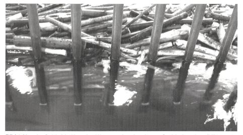
Bild 4. Von der Sohle bis über den Wasserspiegel verlegter Grobholzrechen (LF 2, nach Zugabe von 150 m³ Festholz), von der Rückseite betrachtet und nahe der unteren Rechenstirnseite.
