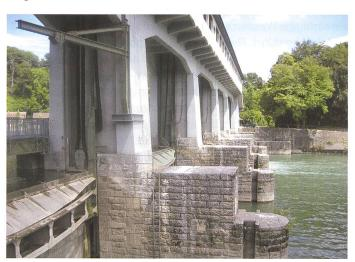
Wasserkraftwerke verwenden die Abflussvorhersagen für die Planung des Betriebs, insbesondere bei Hochwasser. Das Stauwehr Winznau reguliert den Zufluss der Aare zum Oberwasserkanal des Laufkraftwerkes Gösgen. (Foto: Bruno Schädler)
