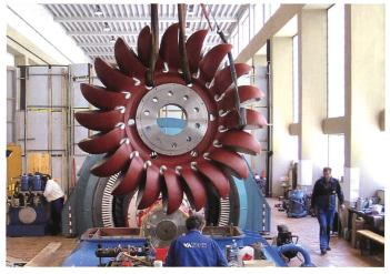
Bild 12. Neueinbau eines Peltonrades mit Leistungssteigerung.
