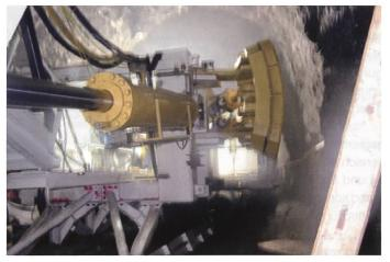
Bild 6. Rückfallsicherung Limberg II (Rowa AG).
