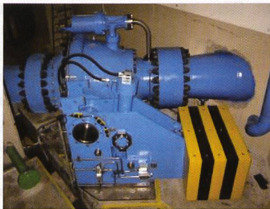
Kugelschieber nach Revision in Betrieb
