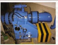
Kugelschieber nach Revision in Betrieb
