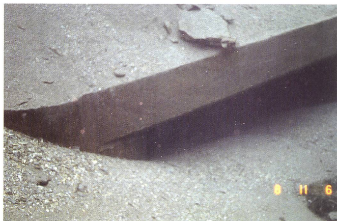
Bild 4. Die Inspektion mit einer Unterwasserkamera hat gezeigt, dass vom drei Meter hohen Einlaufwerk nur noch die obersten 30 Zentimeter sichtbar sind.
