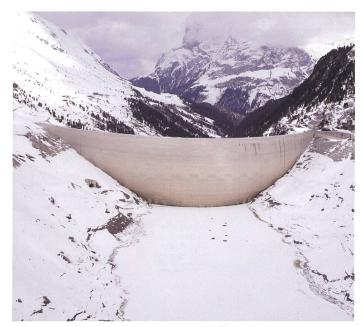
Bild 5. Staumauer Valle di Lei, Bogenmauer: Höhe 138.00 m, Kronenlänge 635.00 m, Nutzvolumen 197000000 m<sup>3</sup>.
