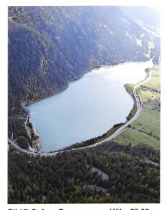
Bild 7. Sufers, Bogenmauer: Höhe 58.00 m, Kronenlänge125.00 m, Nutzvolumen 16000000 m<sup>3</sup>.
