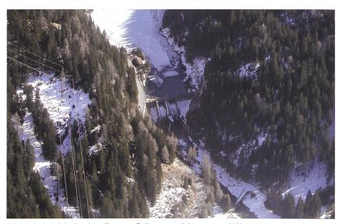
Bild 9. Ausgleichsbecken Ferrera, Schwergewichtsmauer: Höhe 28.00 m, Kronenlänge 61.00 m, Nutzvolumen 230000 m<sup>3</sup>.
