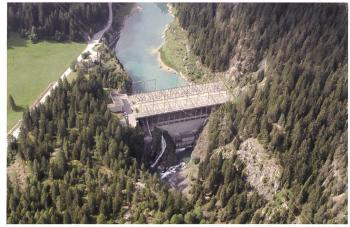
Bild 10. Ausgleichsbecken Bärenburg, Schwergewichtsmauer: Höhe 64.00 m, Kronenlänge 110.00 m, Nutzvolumen 1000000 m<sup>3</sup>.
