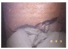
Bild 12. Die Panzerung der Trennwand zwischen den Parallelschützen des Grundablasses ist von den ausgeführten Spülungen stark beschädigt.
