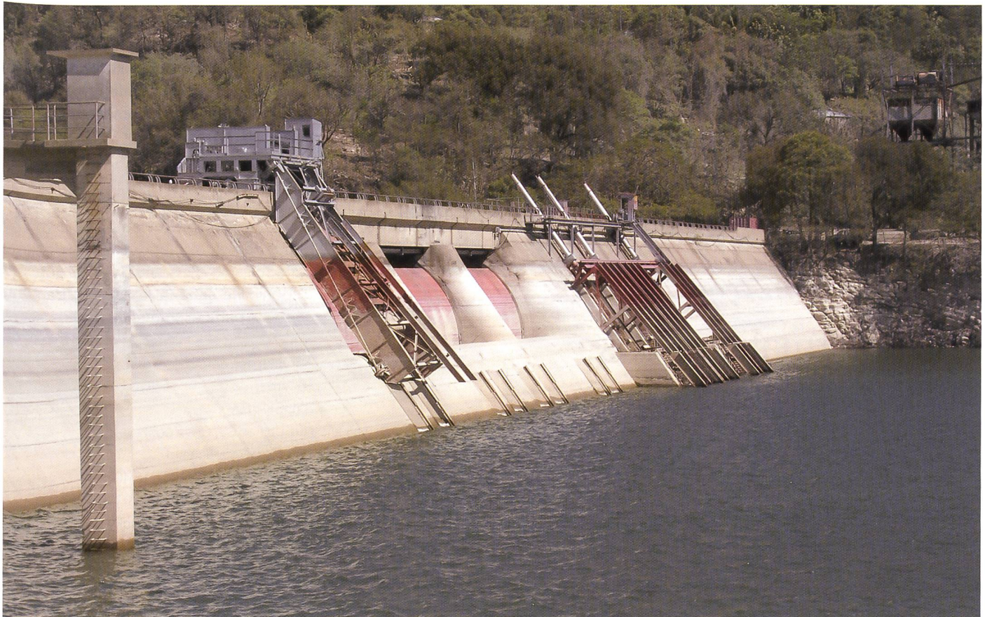
Figure 3. Tour du limnimètre, évacuateur de crue et organes hydromécaniques des vidanges de fond et des prises usinières.
