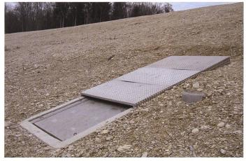
Bild 8. Notentlastung mit Tafelschieber.
