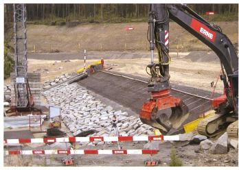
Bild 16. Versetzen von Bruchsteinen auf der Hochwasserentlastung.
