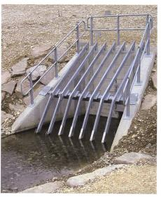
Bild 7. Einlaufbauwerk mit Drosselöffnung und Grobrechen.
