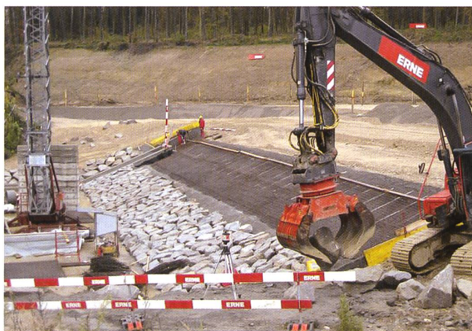
Bild 16. Versetzen von Bruchsteinen auf der Hochwasserentlastung.
