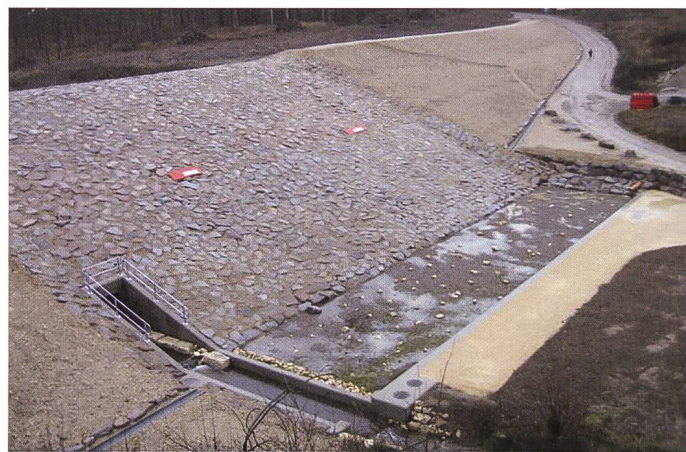
Bild 9. Hochwasserentlastung, Auslauf Durchlass und Tosbecken.
