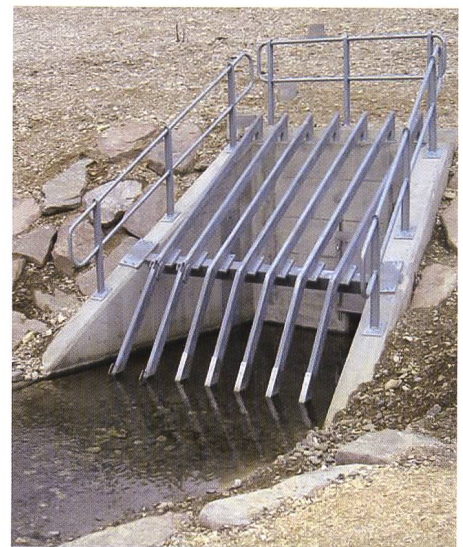
Bild 7. Einlaufbauwerk mit Drosselöffnung und Grobrechen.
