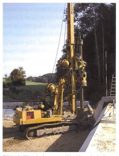
Bild 13. Filterbohrungen (d= 80 cm) als Entlastungsfilter gegen Auftriebssicherheit.
