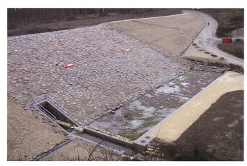
Bild 9. Hochwasserentlastung, Auslauf Durchlass und Tosbecken.
