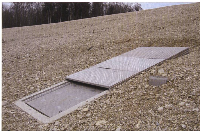
Bild 8. Notentlastung mit Tafelschieber.
