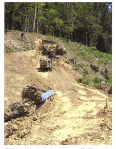
Bild 12. Injektionsbohrungen für Untergrundabdichtung.
