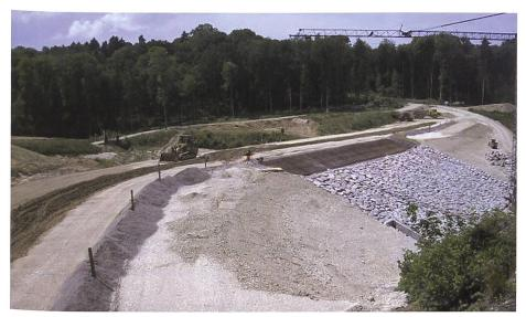
Bild 5. Draufsicht auf Damm mit erkennbaren Dammzonen.
