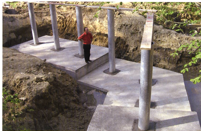
Bild 10. Bauzustand Grobrechen im Stauraum.
