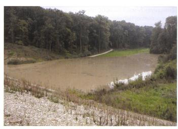
Bild 17. Ersteinstau des HWRB «Isigs Brüggli» am 14. September 2008, 9 Uhr.
