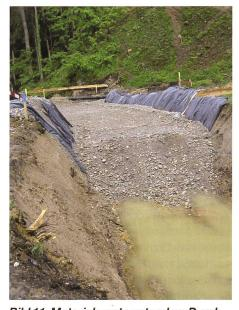
Bild 11. Materialersatz unter dem Durchlassbauwerk.
