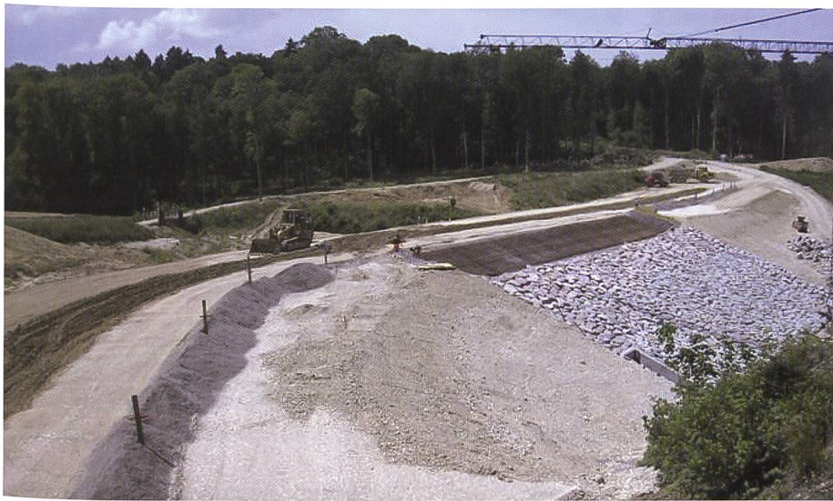
Bild 5. Draufsicht auf Damm mit erkennbaren Dammmzonen.
