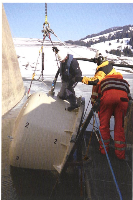
Bild 11. Ausrüsten des Obturators.
