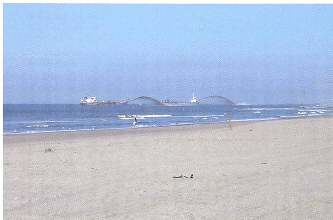
Bild 26. Aufspritzen von Sand an der Küste.
