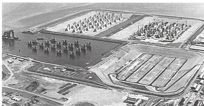
Bild 16. Die Baugrube Schaar mit den vier Docks.
