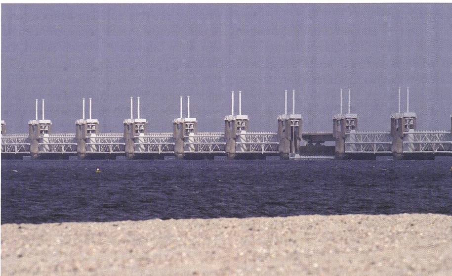
Bild 18. Oosterscheldedam mit einer wegen Unterhaltsarbeiten geschlossenen Stahlschütze.
