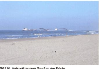
Bild 26. Aufspritzen von Sand an der Küste.
