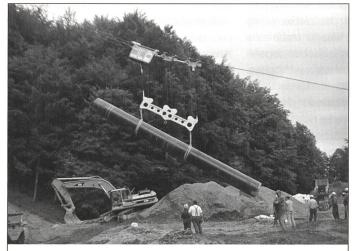
Transport und Versetzen Erdgasleitung, Rohrgewicht 12 Tonnen
