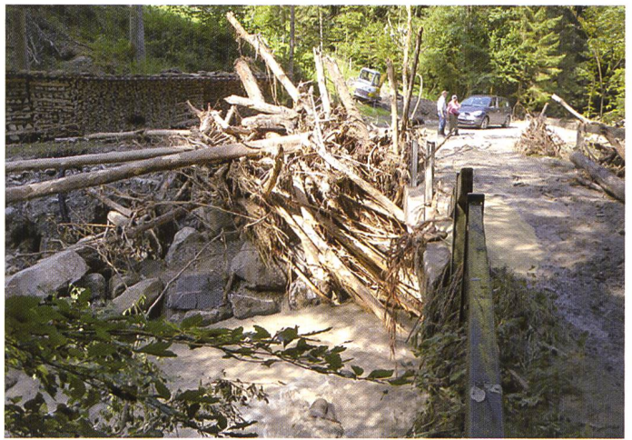
Bild 9. Teilverklausung am Widerlager einer Brücke am Auerbach. (Foto Bänziger Partner AG).
