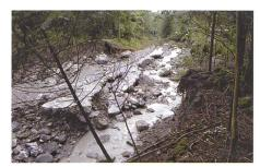
Bild 5. Dürrenbach. Zerstörte Bachschale. Blick in Fliessrichtung. (Foto Bänziger Partner AG).
