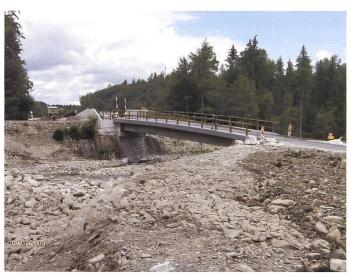
Bild 6. Stalenmoosbrücke, Blick zum linken angehobenen Ufer mit Stirnmauern für die Dammerhöhung und Dammbalkenverschluss. Der linke Schutzdamm ist auf dem Bild noch nicht geschüttet.
