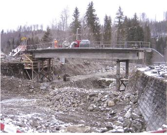
Bild 5. Die angehobene Brücke während der Betonarbeiten an den Widerlagern. Die Stahlkonstruktionen unter der Brücke dienen der Pressenführung und -stabilisierung.
