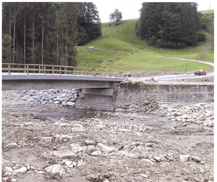
Bild 7. Stalenmoosbrücke, rechtes Ufer mit abgesenktem Überlastkorridor und Strassenwanne.
