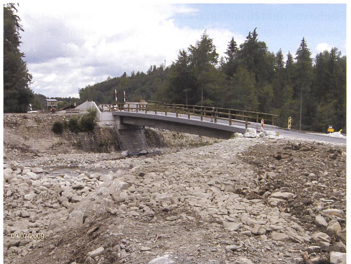
Bild 6. Stalenmoosbrücke, Blick zum linken angehobenen Ufer mit Stirnmauern für die Dammerhöhung und Dammbalkenverschluss. Der linke Schutzdamm ist auf dem Bild noch nicht geschüttet.
