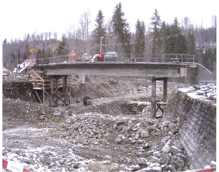
Bild 5. Die angehobene Brücke während der Betonarbeiten an den Widerlagern. Die Stahlkonstruktionen unter der Brücke dienen der Pressenführung und -stabilisierung.
