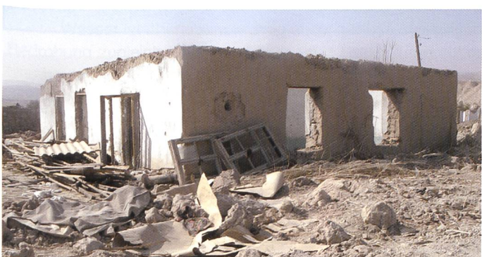
Bild 36. Zerstörungsbild eines Murgangs («Schlammlawine») in Khuroson/Tadschikistan (Bild: DEZA – Humanitäre Hilfe 2009).
