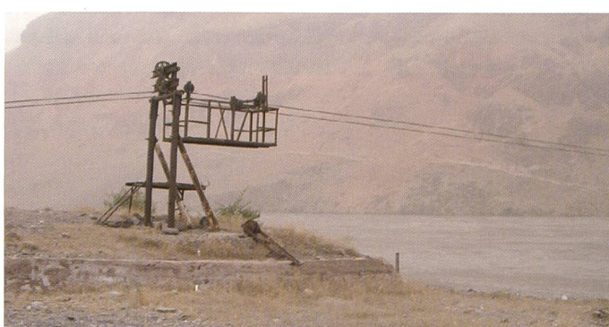
Bild 37. Khirmandschu – Abfluss-Messstation am Pyandj, ausser Funktion, mit Blick nach Afghanistan.
