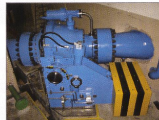
Kugelschieber nach Revision in Betrieb
