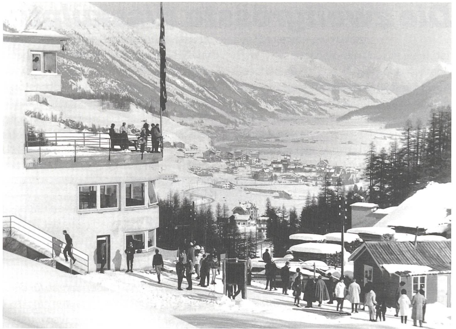
Bild 5. Das Cresta-Clubhaus beim verkürzten Start (Junction), erbaut 1962.
