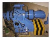
Kugelschieber nach Revision in Betrieb
