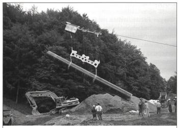
Transport und Versetzen Erdgasleitung, Rohrgewicht 12 Tonnen
