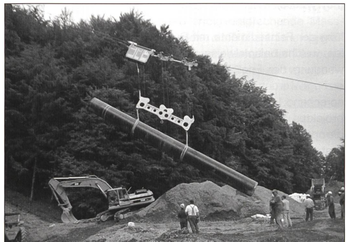
Transport und Versetzen Erdgasleitung, Rohrgewicht 12 Tonnen
