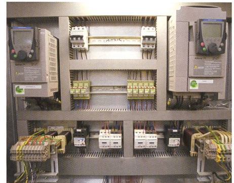
Bild 3. Der Schaltschrank mit der neu installierten Frequenzumrichter-Steuerung.
