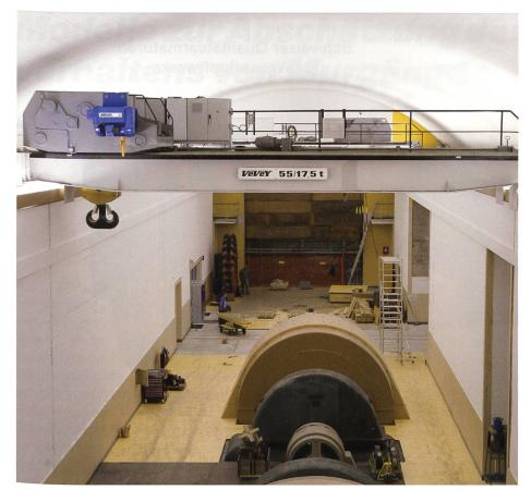
Bild 1. Die Maschinenhalle mit einem der beiden renovierten Zweiträgerlaufkrane für je 55 Tonnen Tragkraft (Bilder: P. Meier).
