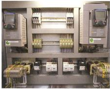
Bild 3. Der Schaltschrank mit der neu installierten Frequenzumrichter-Steuerung.
