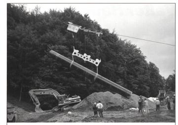
Transport und Versetzen Erdgasleitung, Rohrgewicht 12 Tonnen
