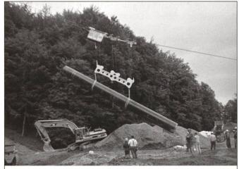
Transport und Versetzen Erdgasleitung, Rohrgewicht 12 Tonnen
