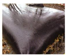
Bild 2. Während der Schlamm im Geotube<sup>®</sup> festgehalten wird, kann das Wasser ausfliessen. (Bild: mmi)
