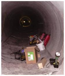
Bild 3. Abwasserwärmeanlage Wässerwiesen Winterthur, Abwasserkanal mit Wärmetauscherelementen, September
