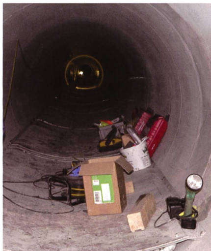
Bild 3. Abwasserwärmanlage Wässerwiesen Winterthur, Abwasserkanal mit Wärmetauscherelementen, September 2009.
