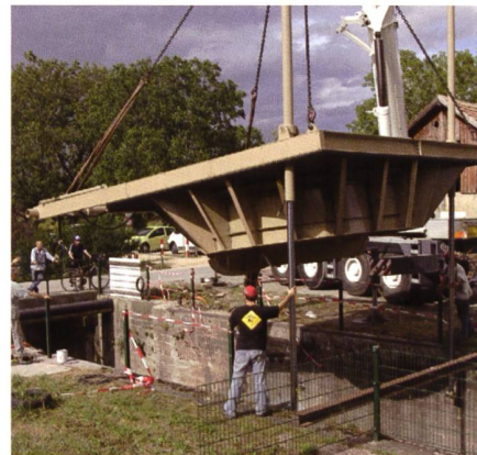
Bild 3. Einbau der Turbineneinheit: Die Schwenkbolzen werden in die Lagerschalen eingesetzt und die beiden Stützen für die Schwenkbewegung positioniert.
