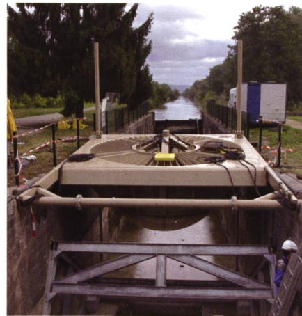
Bild 4. Die Turbine befindet sich in der horizontalen Wartungsstellung über der Schleuse. Nach dem Anschluss der Versorgungsleitungen wird die Einheit um 45° nach unten ins durchfliessende Wasser geschwenkt.
