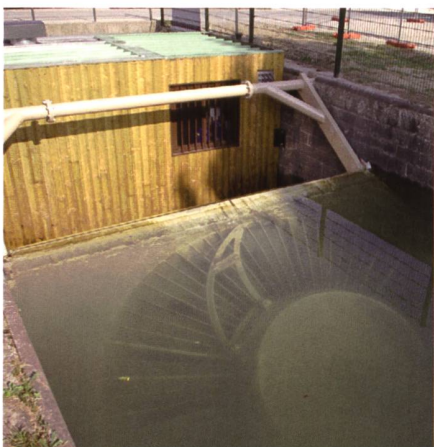
Bild 7. Turbine im Wasserkanal eingeschwenkt.
