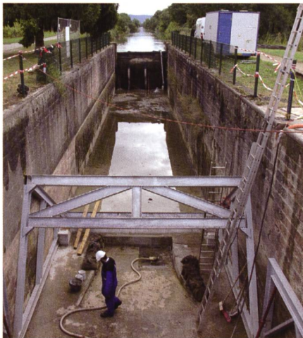
Bild 1. Die ehemalige Schiffschleuse wird für den Einbau der VLH-Turbine bereit gemacht. Die beiden Schwenklagerstellen und die Stahlgerüste für Turbineneinheit und Betriebscontainer sind montiert.
