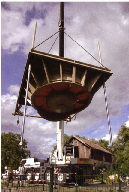
Bild 2. Die Turbineneinheit wird mit einem Pneukran gehoben und in die Schleuse gehievt.
