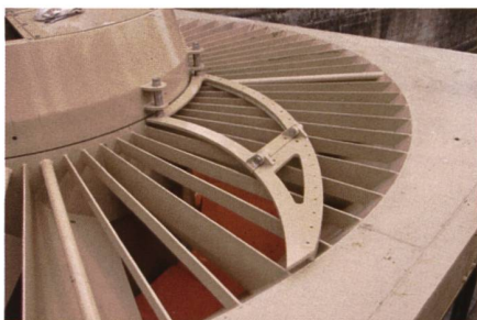
Bild 6. Der Rechenreiniger wird periodisch eingeschaltet und fördert langsam drehend das Geschwemmsel an die Wasseroberfläche.
