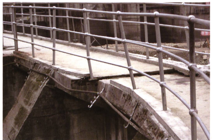
Bild 8. Yingxiuwan: Differentielle Bewegungen an Gehstegfugen.
