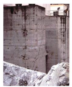
Bild 5. Futan: Schubriss (vermutlich durch Steinschlag) an einem der Wehrpfeiler.
