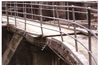
Bild 8. Yingxiuwan: Differentielle Bewegungen an Gehstegfugen.
