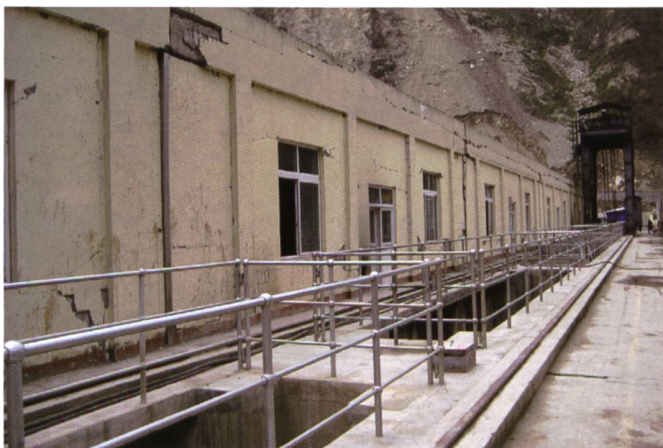
Bild 7. Wehranlage Yingxiuwan: Schäden am Wehrbauwerk.
