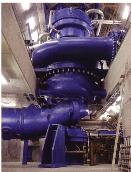
Bild 2. Voith Hydro lieferte für das Kopswerk II Pumpen, Wandler, Kugelschieber und Drosselklappen.
