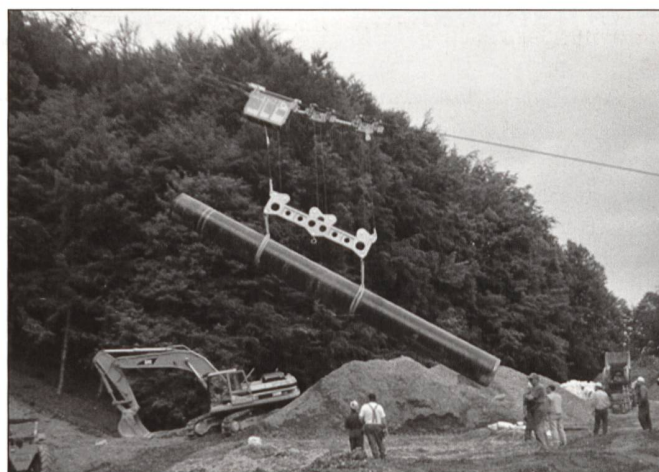
Transport und Versetzen Erdgasleitung, Rohrgewicht 12 Tonnen
