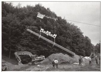
Transport und Versetzen Erdgasleitung, Rohrgewicht 12 Tonnen
