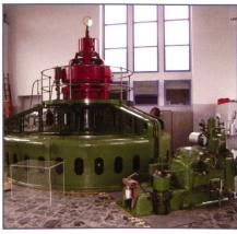
Bild 2. Maschinengruppe 3 des Kraftwerks Aue, Baujahr 1925, mit Francisturbine 1.2 MW und Generator 1800 kVA.
