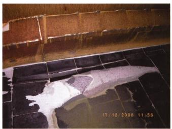
Bild 4. massiver Verschleiss an aufwändiger Basaltpanzerung.
