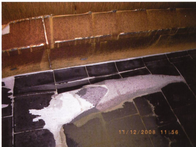
Bild 4. massiver Verschleiss an aufwändiger Basaltpanzerung.
