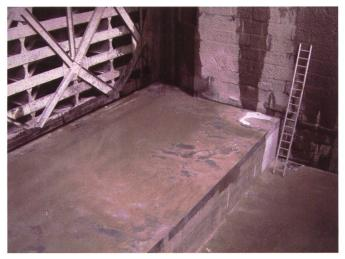
Bild 8. Ausschnitt von einer umgebauten Schwelle.
