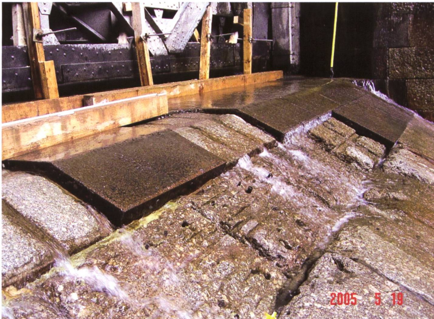
Bild 2. Schäden durch Unterdruck beim Schwellenknicke. Fliessrichtung von links nach rechts, Aufnahme zu Beginn der Trockenarbeiten beim Wehrfeld 1.
