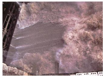
Bild 9. Rund 100 m<sup>3</sup>/s schiessender Abfluss über die neue erste Sohle.
