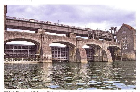
Bild 11. Die obere Hälfte der Wehranlage, die aus dem Unterwasser ragt, wurde durch den Umbau nicht verändert.
