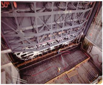
Bild 7. Schalung und Bewehrung für die neue Betonsohle.
