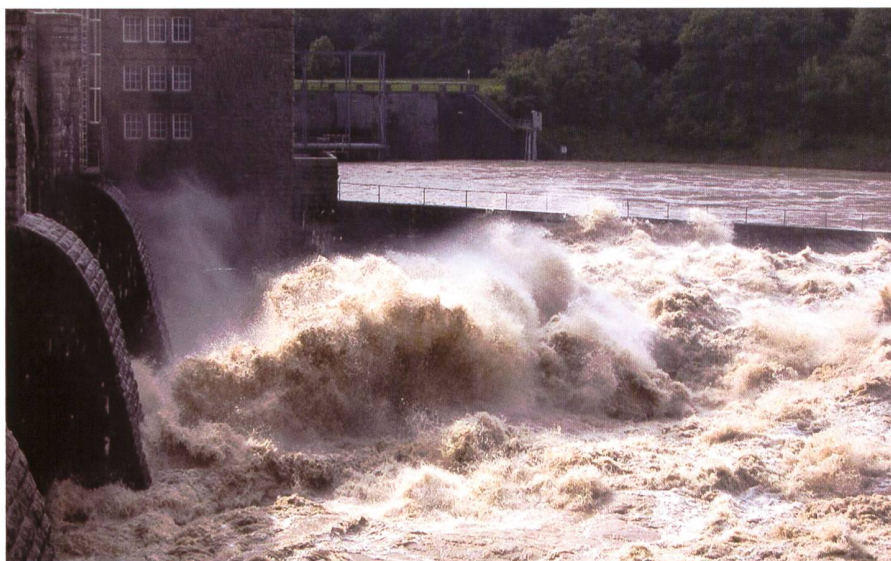
Bild 10. Die Wehranlage mit rund 2200 \text{ m}^3/\text{s} durch zwei Wehrfelder. Im Vordergrund Wehrfeld 3 ohne Abfluss, aufbäumende Wassermassen beim alten Wehrfeld 2 und die lange Dissipationszone nach dem umgebauten Wehrfeld 1 (vor der Betonleitwand zum Kraftwerksauslauf).
