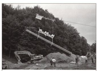
Transport und Versetzen Erdgasleitung, Rohrgewicht 12 Tonnen
