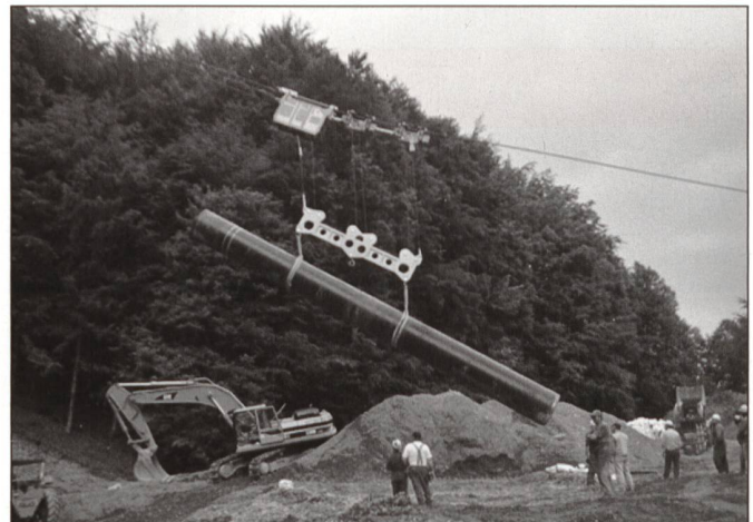
Transport und Versetzen Erdgasleitung, Rohrgewicht 12 Tonnen
