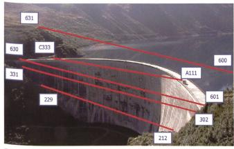
Bild 8. Talquerende Distanzen bei der Staumauer Nalps.
