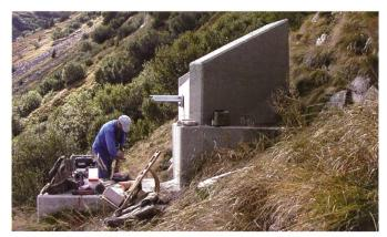
Bild 2. Bau einer Konsole an einem Lawinenschutzkeil.
