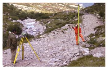
Bild 4. Nivellement im Val Termine.
