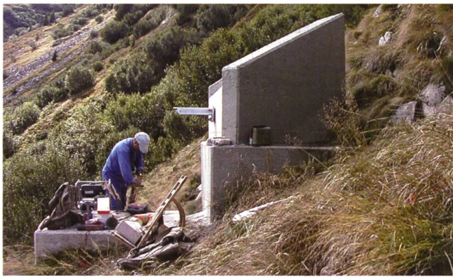
Bild 2. Bau einer Konsole an einem Lawinenschutzkeil.
