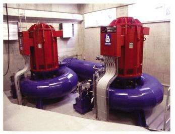
Bild 8. Mit den beiden neu installierten Francis-Spiralturbinen konnte die Leistung von 400 auf 1800 kW erhöht und eine verdreifachte Stromproduktion realisiert werden.
