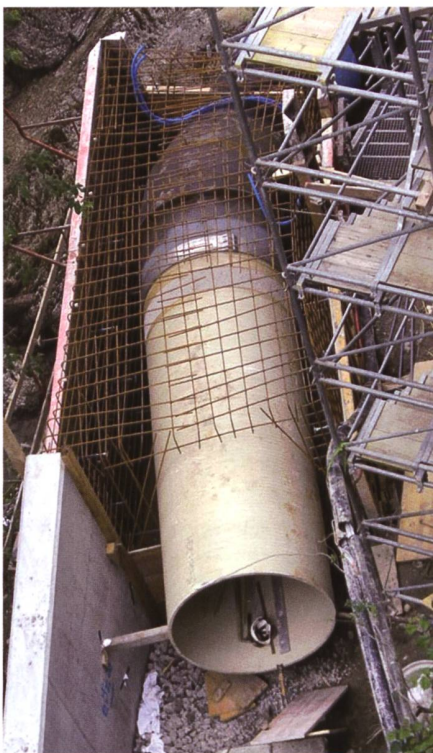
Bild 5. Verlegen der glasfaserverstärkten Druckleitung.
