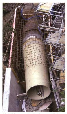
Bild 5. Verlegen der glasfaserverstärkten Druckleitung.
