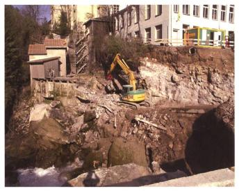
Bild 4. Bauarbeiten für den geplanten Entsander-Teil im Einlaufbereich.
