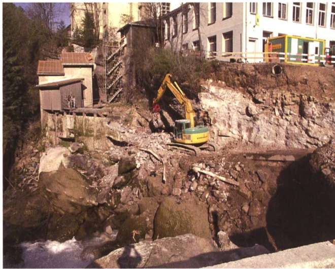
Bild 4. Bauarbeiten für den geplanten Entsander-Teil im Einlaufbereich.
