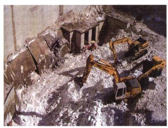
Bild 5. Aufräumarbeiten nach dem Lawinenniedergang auf die Staumauer Ferden 1999.
