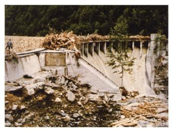
Bild 4. Verklausungen an der Hochwasserentlastungsanlage Palagnedra 1978.
