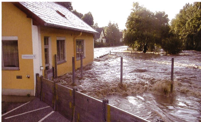
Bild 1. Hochwasser-Schutzwand Typ HSW, 100 cm hoch, 5-fach gestapelt, geschraubt.
