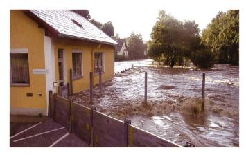
Bild 1. Hochwasser-Schutzwand Typ HSW, 100 cm hoch, 5-fach gestapelt, geschraubt.
