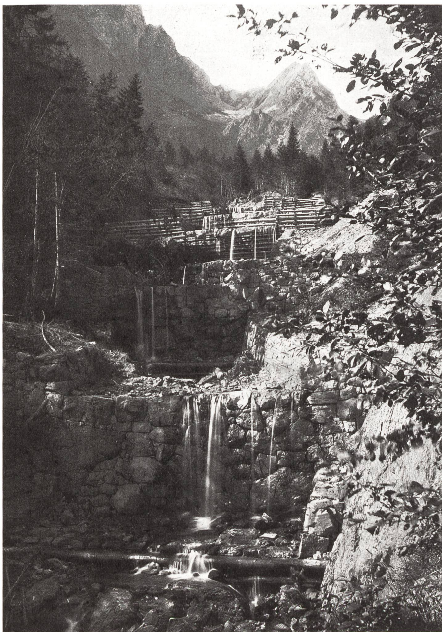
Bild 1. Wildbachverbauung um 1890. Sperren in der sogenannten Hölle am Steinibach bei Hergiswil, Nidwalden («Photogravure des eidg. top. Bureaus»).
