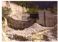
Bild 4. Installation der zweiten Ringnetzbarriere zur Vervollständigung des Umleitbauwerks.
