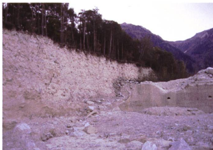
Bild 1. Beschädigte Betonsperre.
