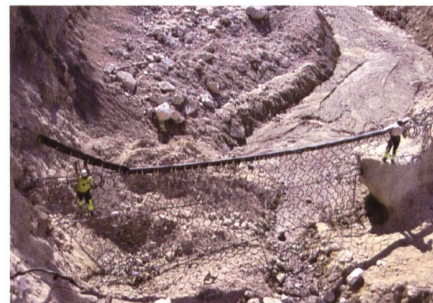
Bild 2. Installation der ersten Ringnetzbarriere.
