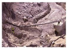
Bild 2. Installation der ersten Ringnetzbarriere.
