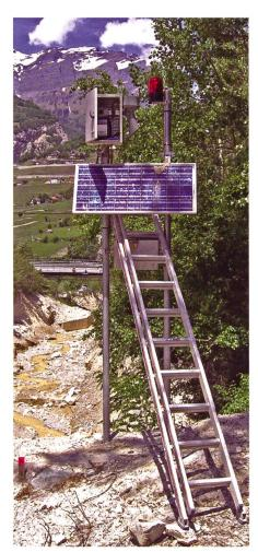
Bild 3. Alarmeinrichtung mit Blinklicht und Sirene auf Sperre 28. Im Hintergrund die Kantonsstrassenbrücke über den Illgraben.
