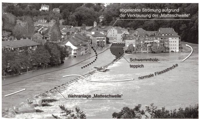
Bild 1. Situation an der Matteschwelle in Bern während des Hochwassers am 22. August 2005 bei einem Abfluss von ca. 600 m³/s. Das Mattequartier, im Hintergrund, wird zu diesem Zeitpunkt vom Oberwasser her durchströmt. Foto: K+H.
