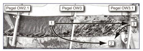
Bild 9. Schwemmholzansammlung im hinteren Bereich der Matteschwelle zwischen Zähringer- (links) und Inseli-Grundablass (rechts), die Pfeile zeigen den typischen Strömungsweg (Ziffern zur Beschreibung) durch die Ansammlung.
