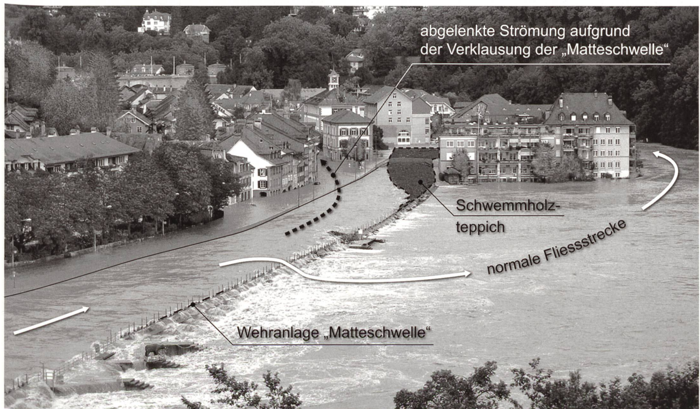
Bild 1. Situation an der Matteschwelle in Bern während des Hochwassers am 22. August 2005 bei einem Abfluss von ca. 600 \text{ m}^3/\text{s} . Das Mattequartier, im Hintergrund, wird zu diesem Zeitpunkt vom Oberwasser her durchströmt. Foto: K+H.
