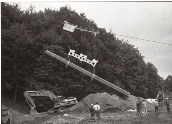
Transport und Versetzen Erdgasleitung, Rohrgewicht 12 Tonnen
