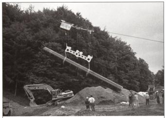
Transport und Versetzen Erdgasleitung, Rohrgewicht 12 Tonnen
