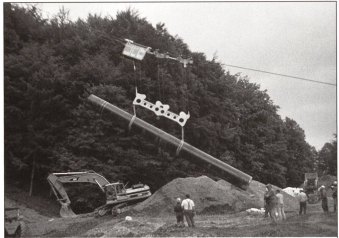
Transport und Versetzen Erdgasleitung, Rohrgewicht 12 Tonnen
