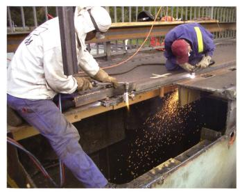
Bild 12. Aufschneiden des Kranbahnträgers.
