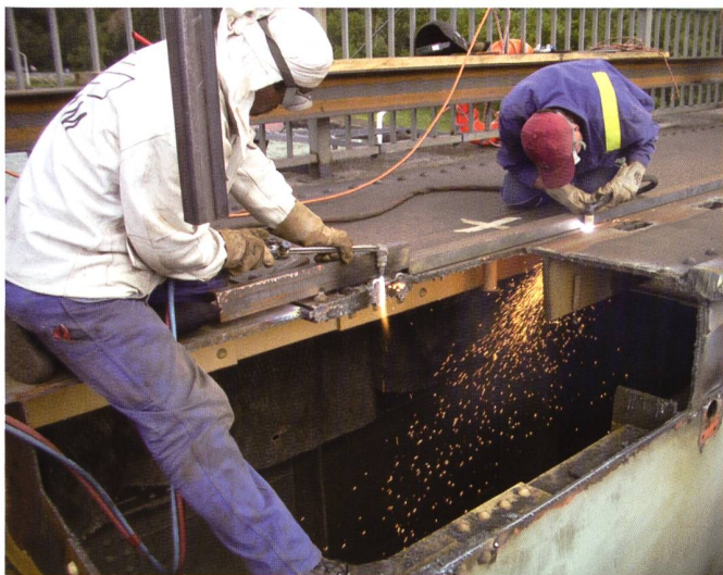
Bild 12. Aufschneiden des Kranbahnträgers.
