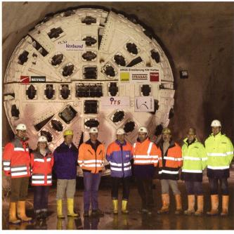
Bild 8. Fräskopf im Verzweigungsbereich des neuen Triebwasserweges.
