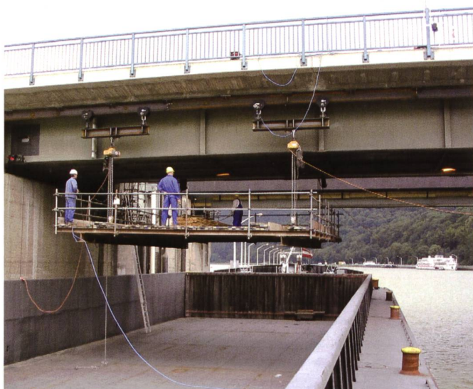
Bild 8. Ausheben des Hängegerüsts aus dem Schwimmponton.
