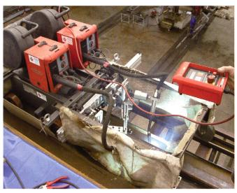
Bild 13. Anschweissen der Kranbahnschienen mittels Roboter.
