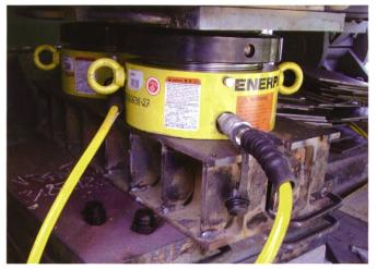
Bild 10. Heben der Kranbahnträger.
