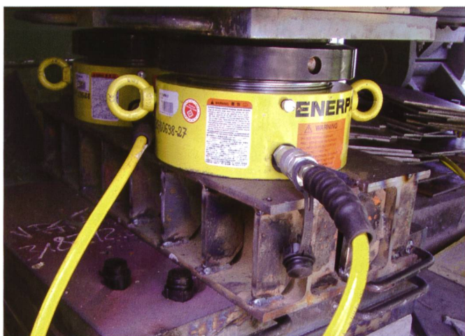
Bild 10. Heben der Kranbahnträger.
