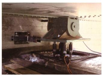
Bild 11. Kranbahnträger in gehobenem Zustand.
