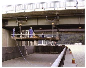
Bild 8. Ausheben des Hängegerüstes aus dem Schwimmponton.
