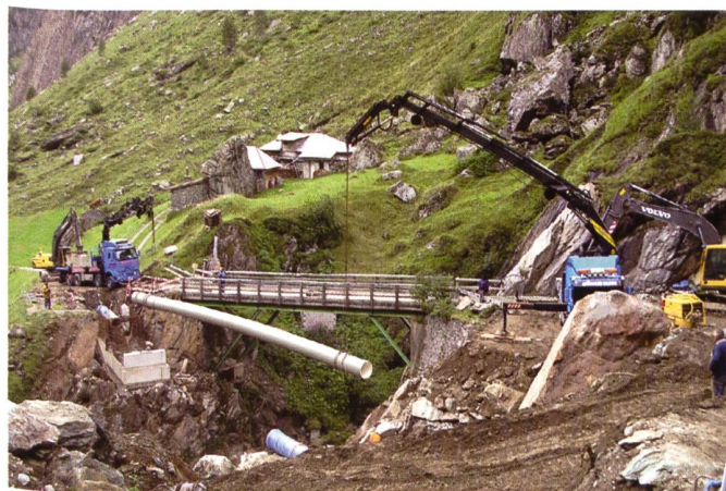
Bild 3. Montage einer 23 m langen Stahlrohrbrücke.
