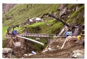
Bild 3. Montage einer 23 m langen Stahlrohrbrücke.
