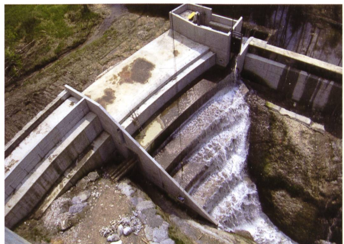
Bild 6. Kaskadenschussrinne über die nach vorn abgestützte Pfeilermauer.
