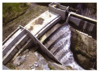
Bild 6. Kaskadenschussrinne über die nach vorn abgestützte Pfeilermauer.
