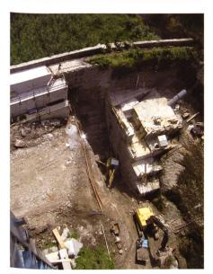
Bild 7. Etappenweises Vorgehen beim Bau zum Erhalt der Standsicherheit im Bauzustand.
