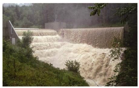
Bild 9. Kaskadenabfluss beim Hochwasserereignis vom 17. September 2006.
