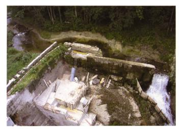
Bild 5. Bestehende Hochwasserentlastung (Streichwehr) während der Bauausführung. Man beachte die erodierte Zone an der Engstelle am linken Widerlager.
