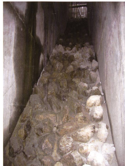
Bild 10. Entleerte obere Kammer der Fischschleuse mit einer Sohle aus Natursteinblöcken.
