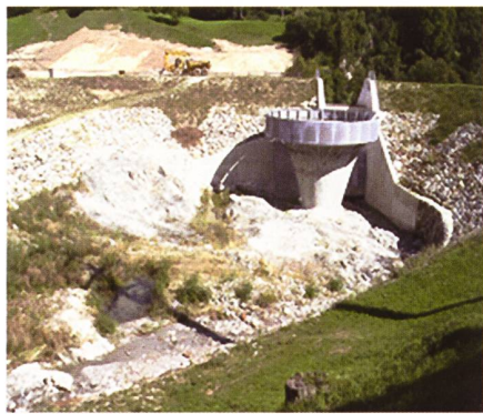
Bild 2. Sicht flussabwärts auf Geschiebesammler mit Einlaufbauwerk der Hochwasserentlastung und Auslaufbauwerk. Links: Das ausgeführte Bauwerk. Rechts: Das hydraulische Modell im Massstab 1:30.
