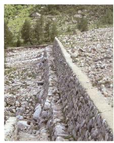
Bild 2. Kiesfang vor der Mündung des Palübaches in den Palüsee.
