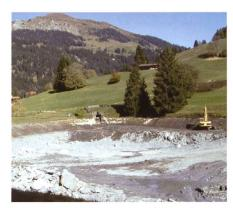
Bild 10. Plävigginbecken während Optimierung des Stauvolumens.
