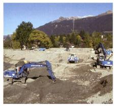
Bild 9. Ausbaggerung des Aeujabeckens nach dem Hochwasserereignis von 2005.
