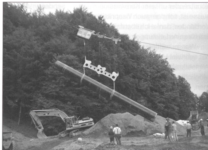
Transport und Versetzen Erdgasleitung, Rohrgewicht 12 Tonnen
