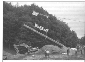
Transport und Versetzen Erdgasleitung, Rohrgewicht 12 Tonnen
