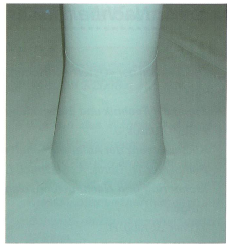
Bild 2. Aufgrund geringem Materialgewicht und bewährter Schweissttechnik stellt das Auskleiden von Säulen kein Problem dar.
