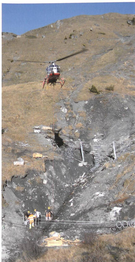
Bild 2. Installation der Barrieren.
