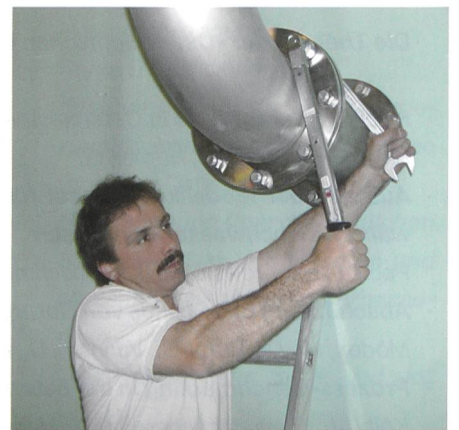
Bild 3 links und Bild 4 rechts. Sämtliche Anschlüsse wurden mit Doppelklemmflanschen ausgerüstet. Die alten Zu- und Ableitungen wurden durch solche aus Chromstahl ersetzt.
