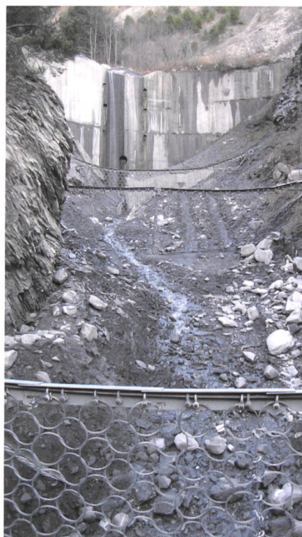
Bild 11. Mehrstufige Verbauung Merden-sen, Schweiz.
