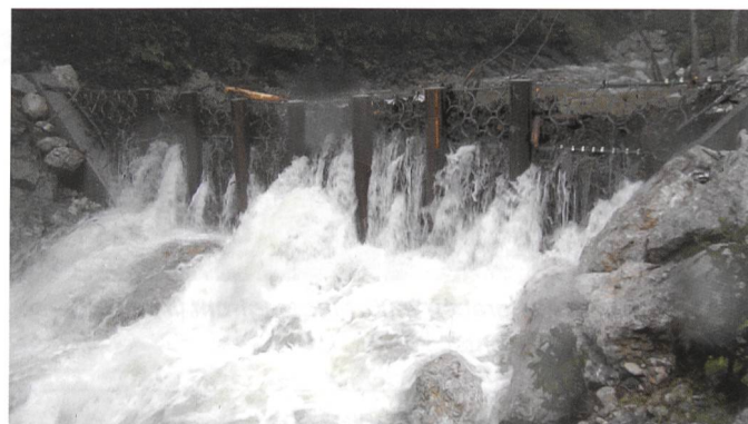
Bild 7. Beispiel von installierter Ringnetzsperrung zum Schwemmholzurückhalt in Österreich.
