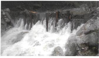
Bild 7. Beispiel von installierter Ringnetzsperre zum Schwemmholzrückhalt in Österreich.
